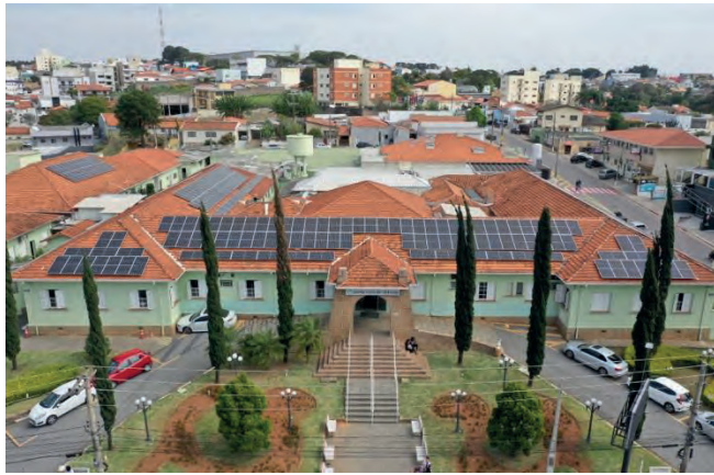
Imagen 2. Instalación en hospital por parte de CPFL
