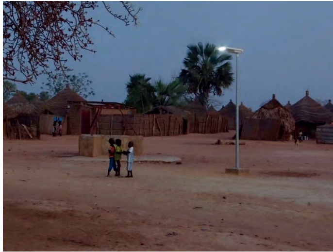
Imagen 1. Ejemplo de luminaria con panel solar en zona rural
